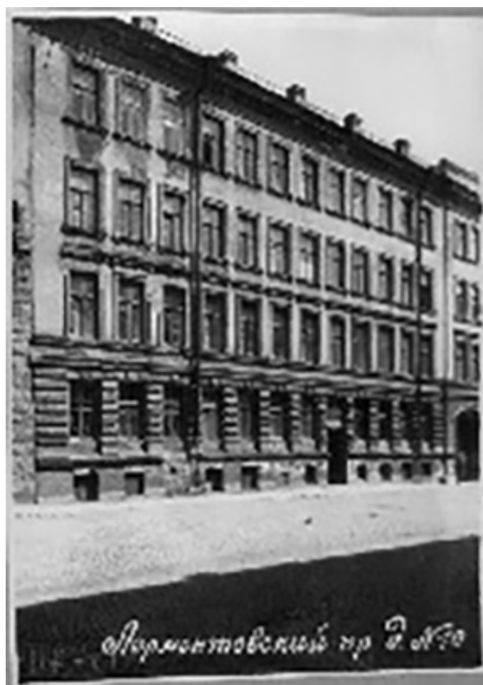
Рис. 4. Вид центрального фасада дома № 10 на Лермонтовском проспекте. Архитектор Павел Данилович Шретер, год постройки — 1822. Центральный государственный архив кинофотофонодокументов Санкт-Петербурга. Архивный шифр ЦГАКФФД СПб. Гр 71141, дата съемки — 1949 г. (Источник: https://spbarchives.ru/infres/-/archive/cgakffd/photo/gr71141 )
